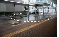
建物名称:駅前バスストップ 部 位: 歩行面 構造形式: S 造 詳細部位: 路 面 発生箇所:パスストップ 材 料: タイル 発生要因:施工不良 症 状:水溜まり・不陸
