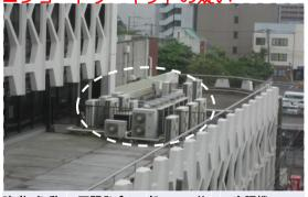
建 物 名 称 : 再開発ビル 構造形式: RC造 詳細部位: 発 生 箇 所:屋上一空調機 材 発 生 要 因 : 施工不良 状: 機能障害 影 経済性 竣工年: 責任の所在: 設計者(設備) 撮 影 年: 2023
