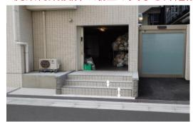
建物名称: 分譲マンション 部 位 外階段 構造形式: R C 造 詳細部位: 最下部 発生箇所: 廃棄物集積所 材 料: コンクリート 発生要因: 施工不良 症 状:蹴上寸法が異なる 影 響:安全性の不備竣工年: 2023 責任の所在: 設計者 撮影年: 2023
